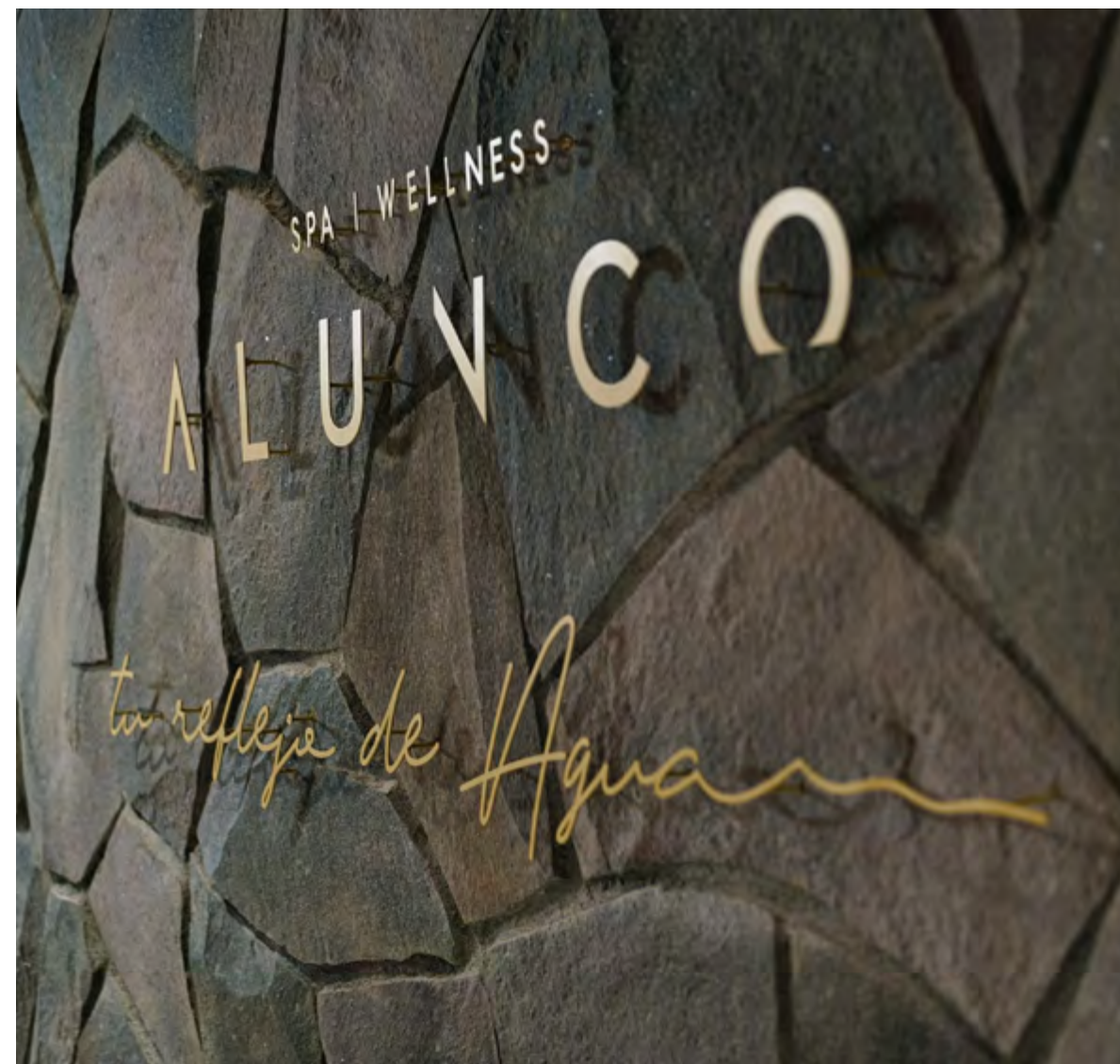
CORTE CNC DE ALUMÍNIO LACADO A DOURADO AO FORMATO E FIXADORES AFASTADORES
